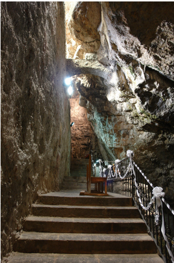
Foto 9. Tramo central de escalera, frente a la Capilla.
