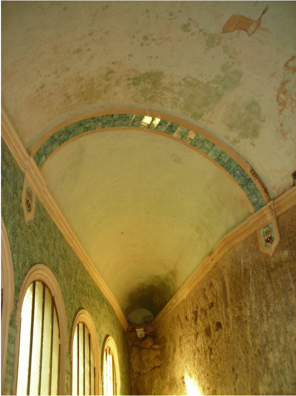
Foto 2. Bóveda de cañón de la zona de acceso.
