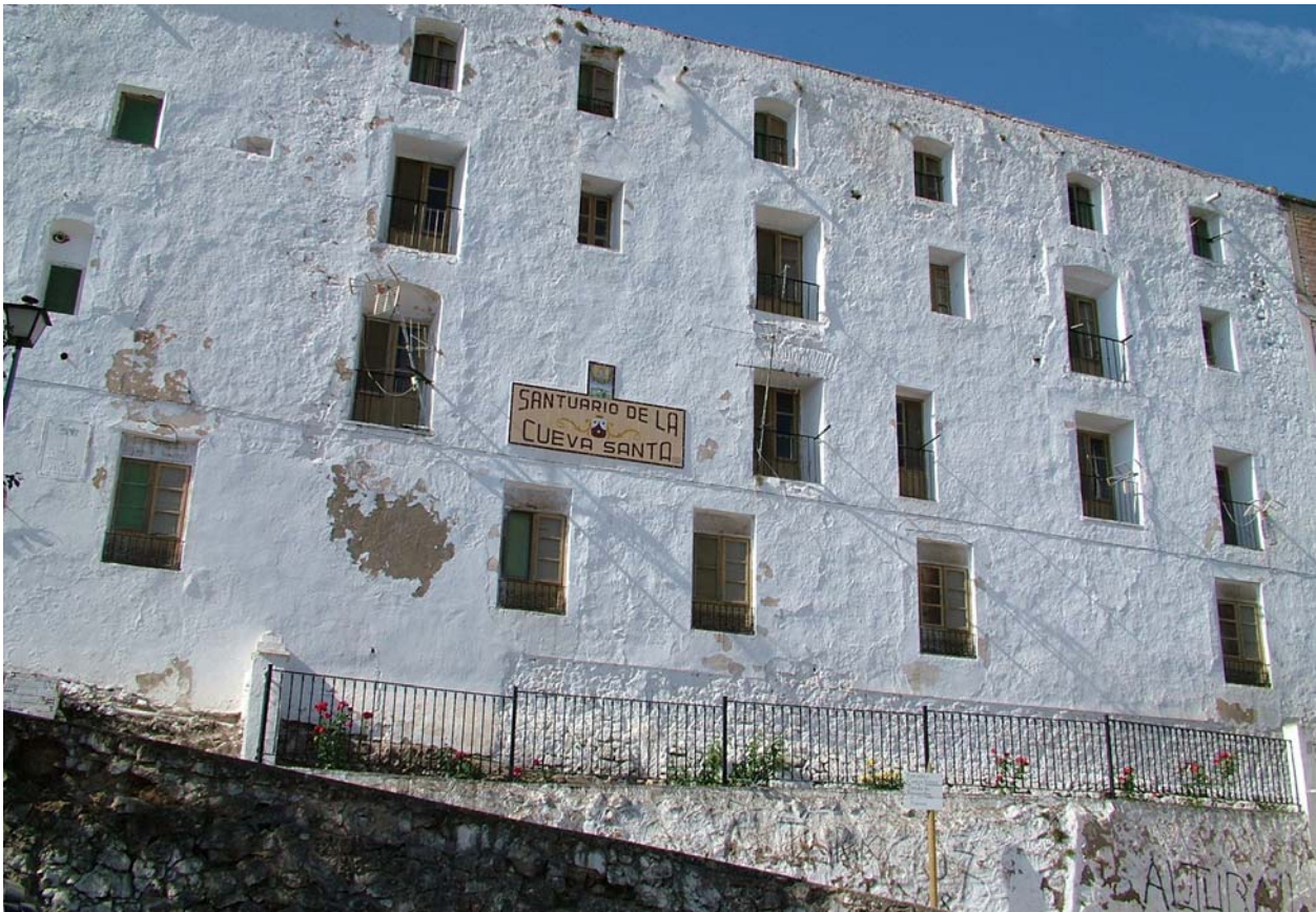
Foto 2. Estado actual de la Hospedería.
