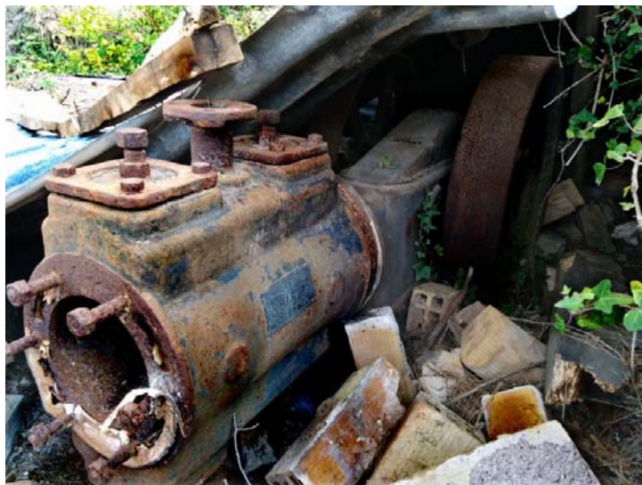
Restes del compressor de Santa Bàrbara
