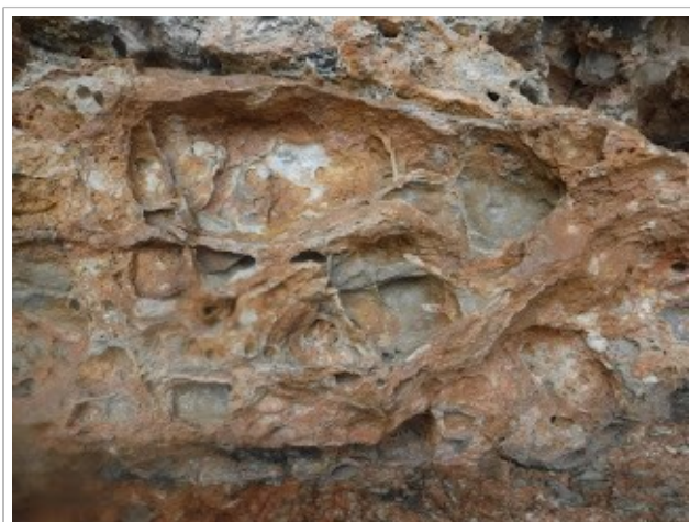
Aspecto de las brechas corroídas por la salinidad del ambiente
