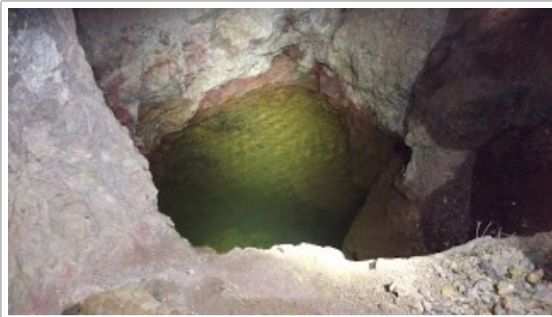
16. Pequeño pozo inundado.
