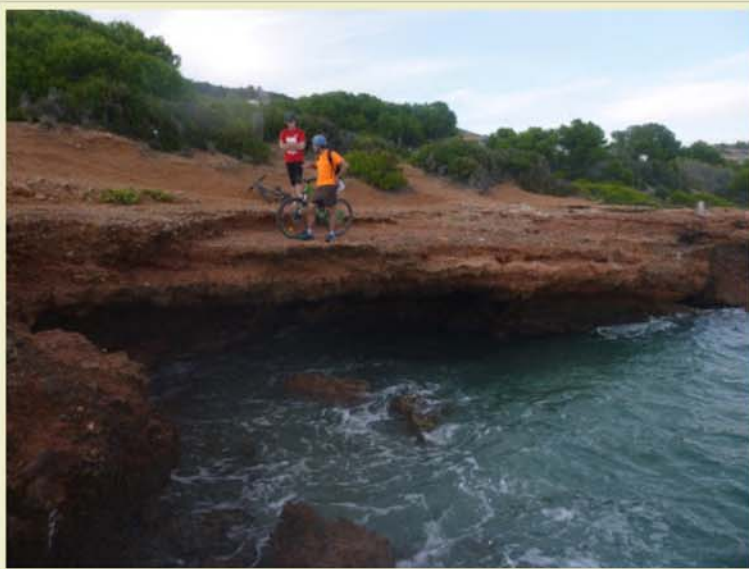
Cova B-5, on es veu clarament l'acció erosiva de la mar.
