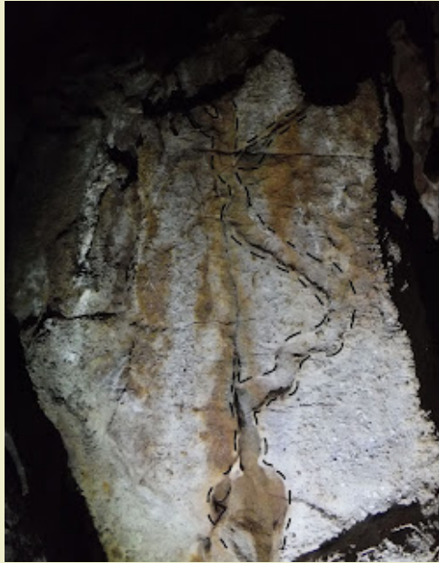
Canal de bóveda ubicado en la parte intermedia de la galería.
