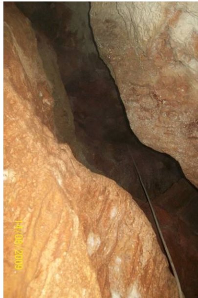
DETALLE DE LA FRACTURA
