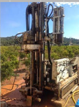
Sondeo geotecnico en Castellón
