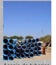
Acopio de tuberías
