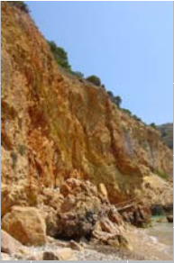
Desprendimientos (Cabo de la Nao)
