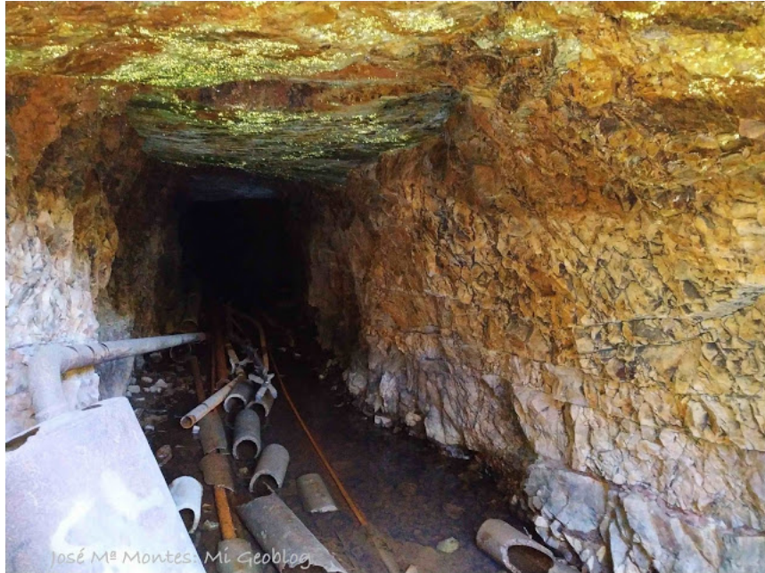
Figura nº 15: Interior inundado de la Galería del Socavón.
