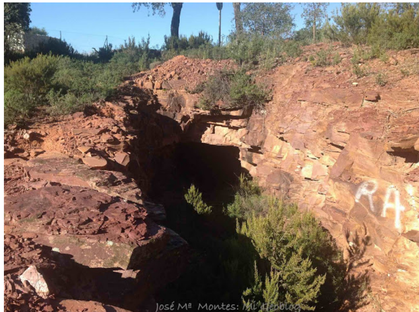
Figura nº 19: Boca de una galería excavada en las limitas y areniscas rojas.
