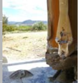
Boca de trepano re
