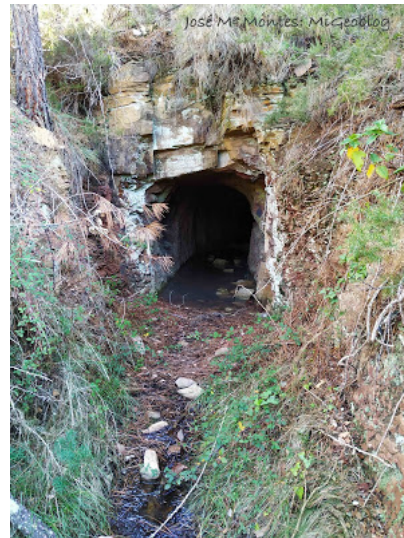
Figura nº 22: Bocamina de la Galería Diana.
