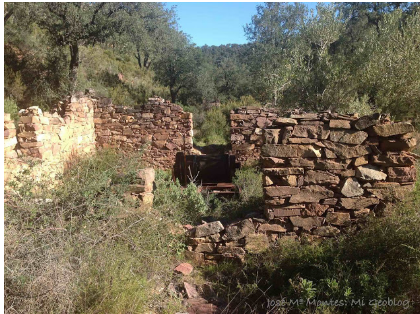
Figura nº 16: Casa de maquinas del Pozo Manuel (El Hembrar; Chovar)
