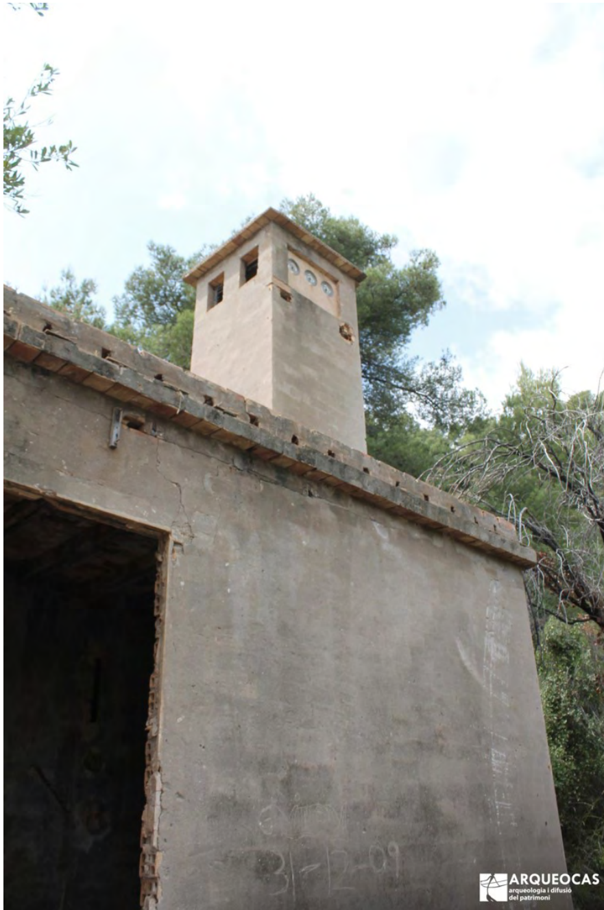
Transformador eléctrico de la Mina (Foto: Arqueocas)
