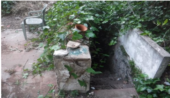
Entrada inferior. la galeria d'aigua.
