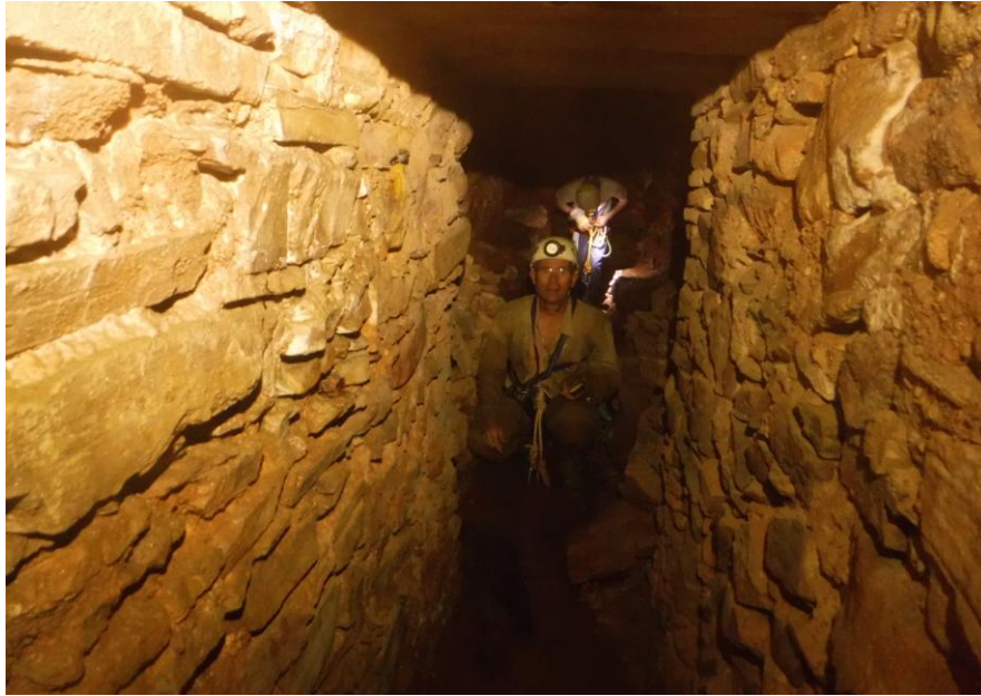
Tram de la galeria principal, amb pedres i mortres a les parets
