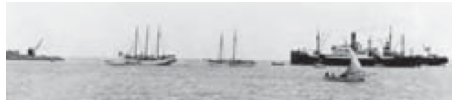
En esta fotografia dels anys trenta presa a la banda de garbí del port de Borriana, es poden veure, d'esquerra a dreta, dos pailebots, una llanxa, dos vapors de transport de taronges i una barca de pesca amb vela llatina.
