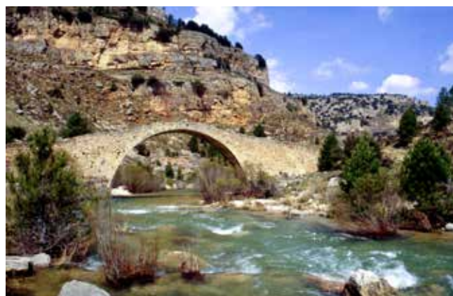
Pont de les Calçades, entre Vistabella i Mosquerola
