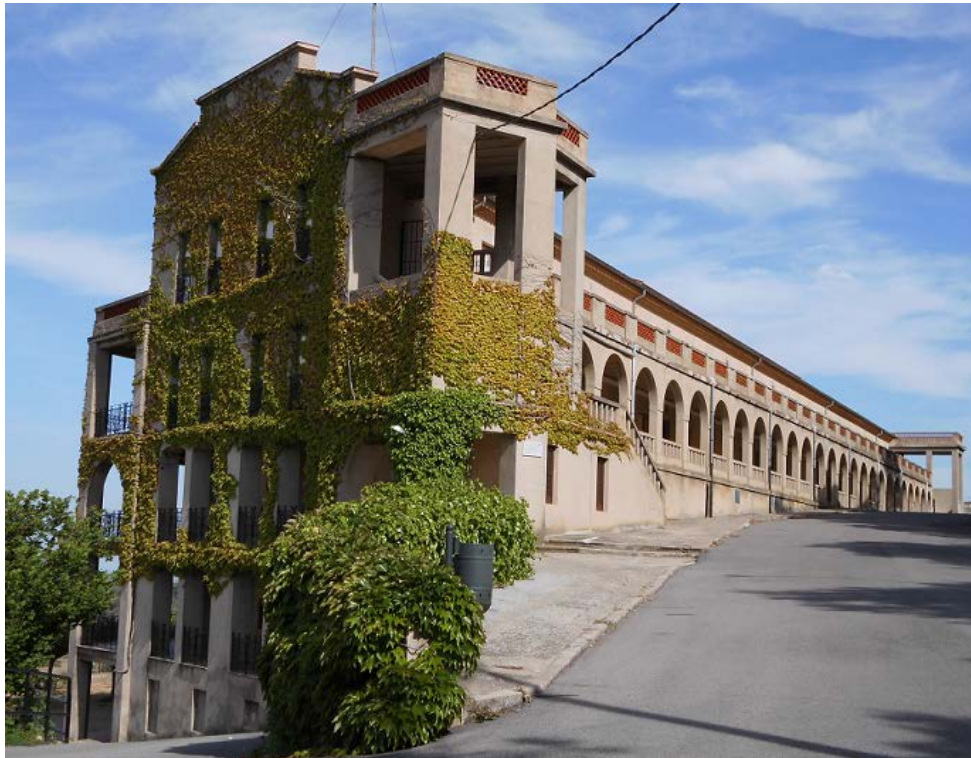
FOTOGRAFIA 2. PARADA 2 Un aspecte de les construccions del centre termal
