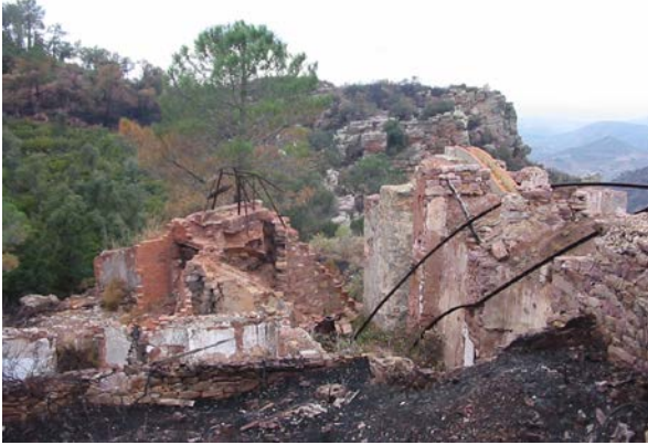
FOTOGRAFIA 8. Algunes de les instal·lacions mineres en estat totalment ruïnós
