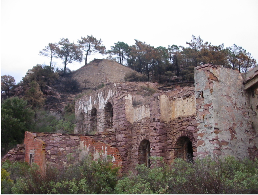
FOTOGRAFIA 6. Un aspecte de les instal·lacions mineres de Chovar / Xóvar. Els forns de tractament dels minerals estrets
