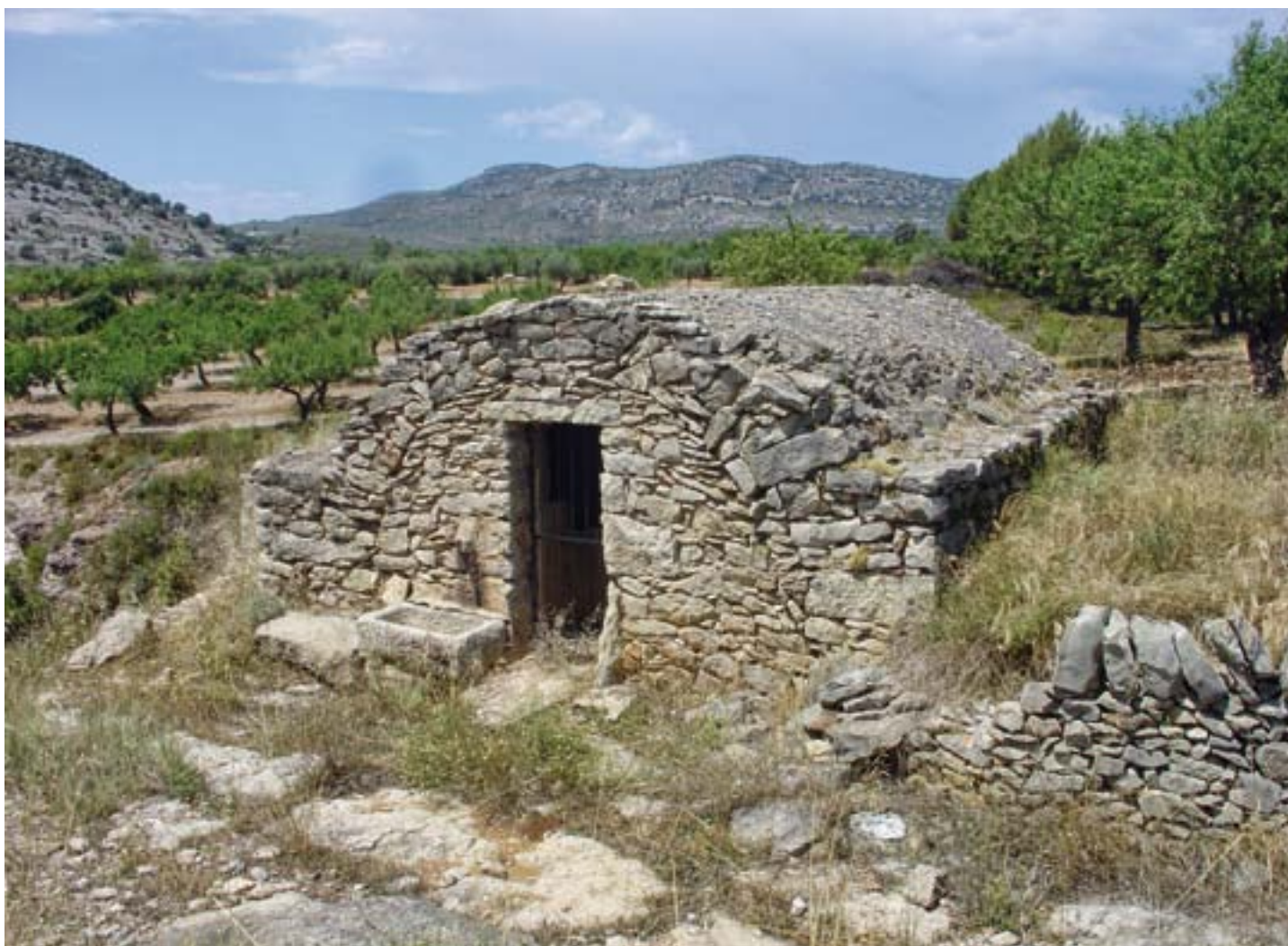
Figura 11. Los aljibes denotan la necesidad de almacenar hasta la última gota de agua en estas tierras (foto autores)
