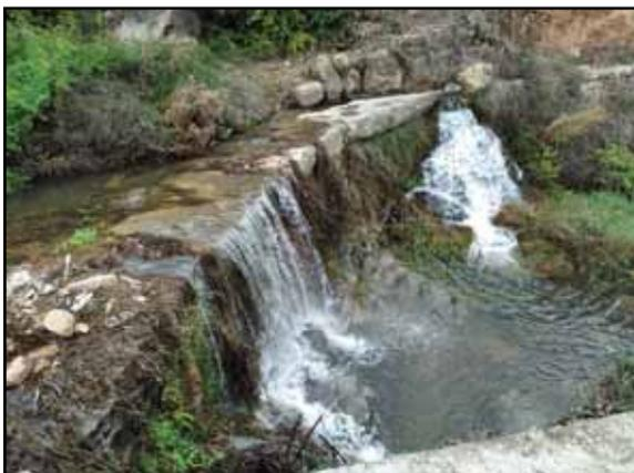
Figura 27: Perdida del “assut del barranc d’Eslida” tras una crecida.
