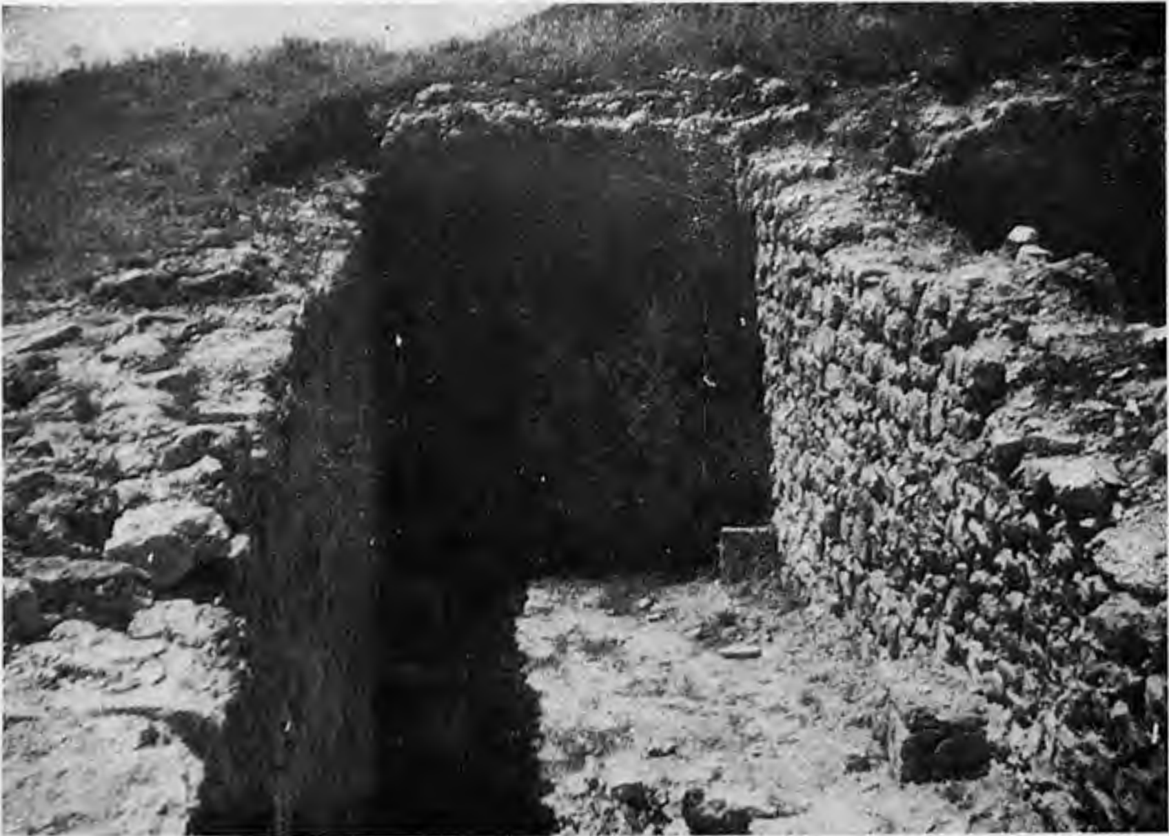
Aspecto parcial del aljibe n.º 1 una vez excavado
