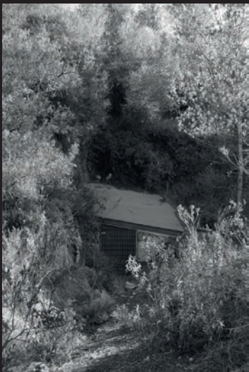
Aspecte actual de la boca de l'avenc de Fondegulla, cobert amb un sostre i una reixa que permet l'entrada de l'aigua de les riuades i alhora evita que es llancen brutícies o es produïska algun accident.
