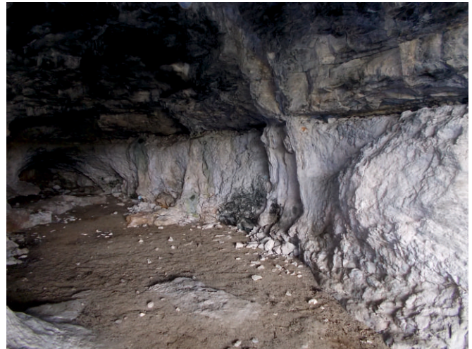
Figura 4: Zona de entrada de la Cova de la Vall donde se aprecia la junta de estratificación a lo largo de la galería.
