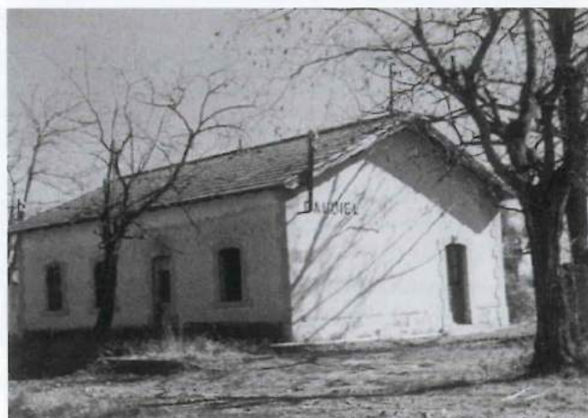
Caudiel. Estado de la Estación Minera.
