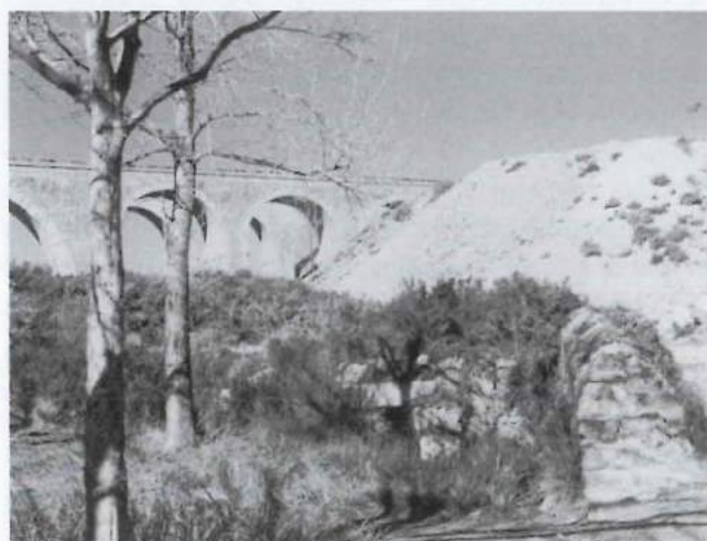
Caudiel. Viaductos del Central de Aragón y de la Compañía Minera. En un primer plano el nacimiento de la Fuensanta.
