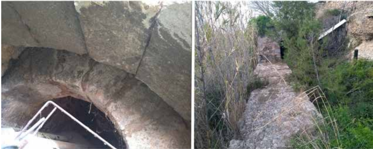
FIGURA 5. Arco con dos filas de piedra picada para introducir un madero en el medio (portal caladizo) y detalle del muro del cajero exterior de la antigua acequia que nació de la Caseta dels Moros y que usaba la roca del río como cajero interior, hoy día cubierto por vegetación (año 2020).
