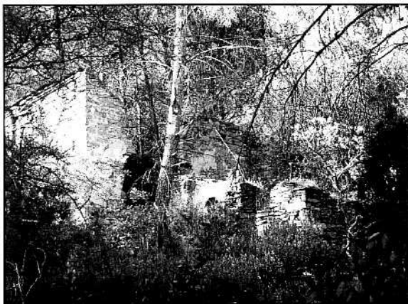
Estat actual de la casa de la Solana de la Mina (Eslida)
