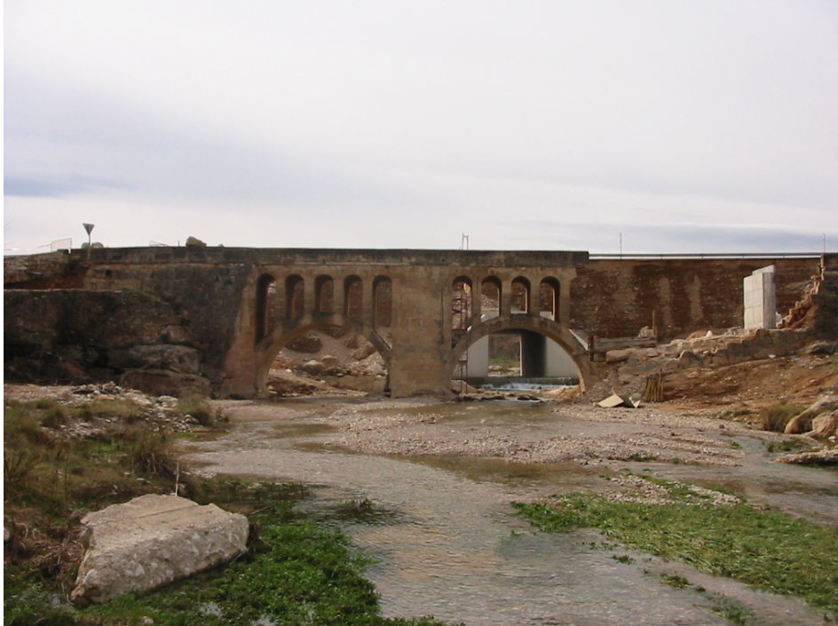
FOTOGRAFIA 1. PARADA 2 En primer terme el Pont Medieval (amb tres “ulls”) i al darrera el pon nou (amb un sol “ull”)
