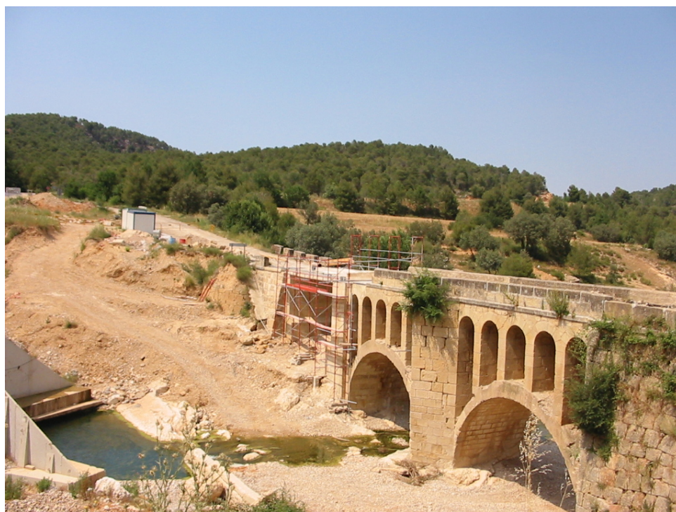
FOTOGRAFIA 3. PARADA 2 Un altre aspecte del pont nou
