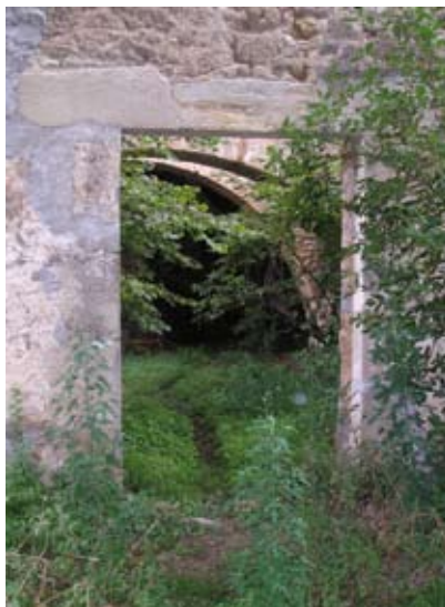
Fig.8, Porta d'entrada a la Fàbrica del Ferro des del riu Sénia
