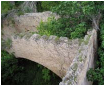
Fig.7, Vista des de dalt de les arcades de la Fàbrica del Ferro
