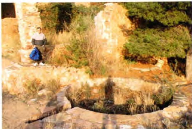
Mesa durmiente circular correspondiente al primer nivel donde quedaba separada la galena del resto del mineral por sedimentación.
