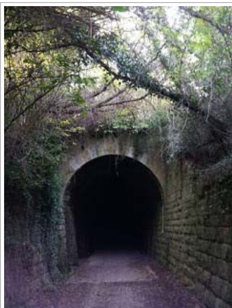
Boca oeste del túnel de la Minera en Caudiel.
