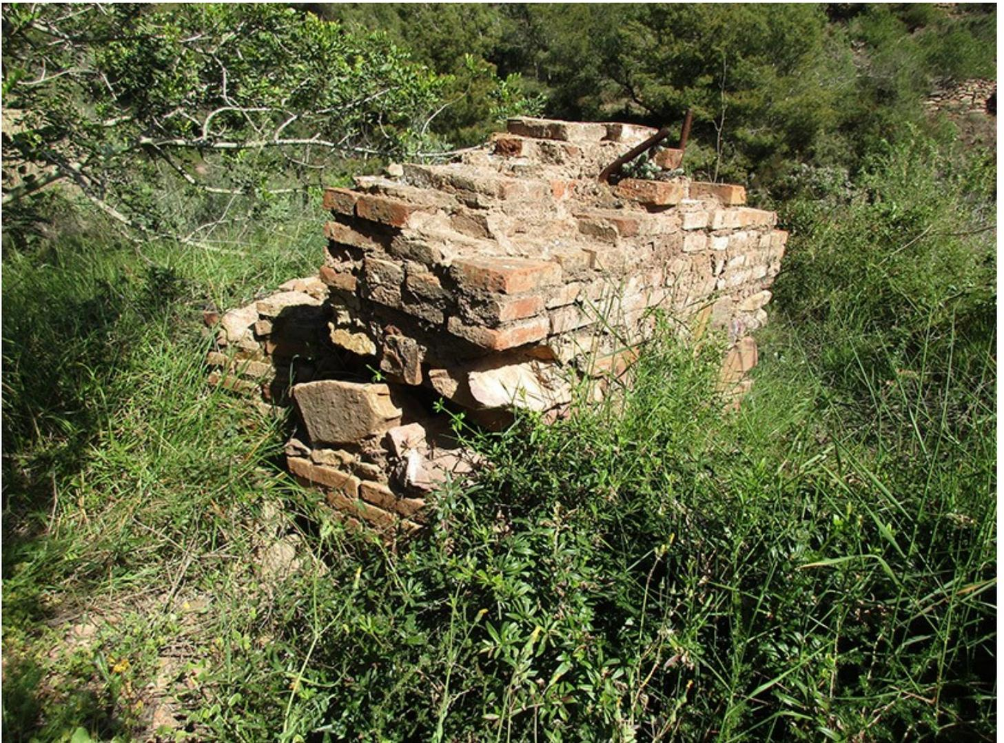
Restos de la pilastra, realizada en ladrillos, que mantenía la polea inferior del sistema aéreo.
