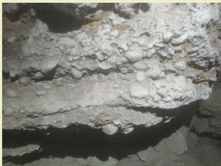
Detalle del relleno emplazado por debajo de la estalagmita.
