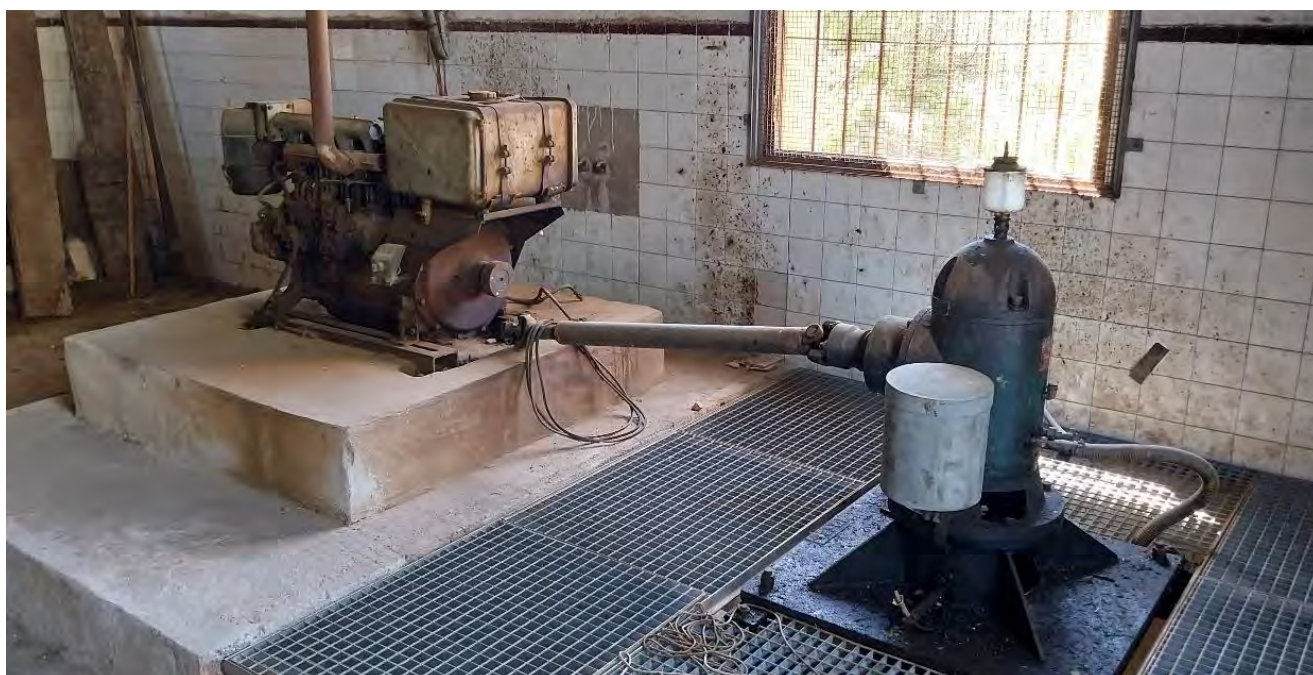
Figura 16: Equipo de bombeo instalado en el pozo de caja situado en el recinto del Molí la Font
