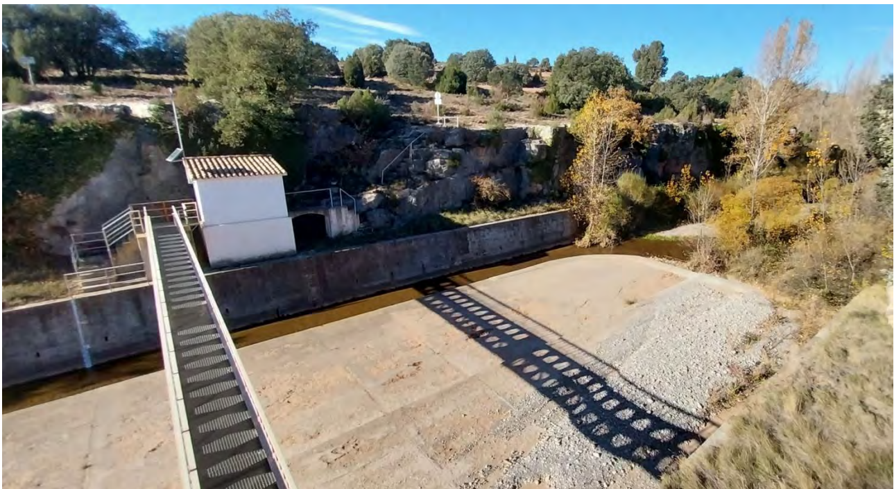
Figura 38: Estación de aforo de la CHJ en el río Mijares.
