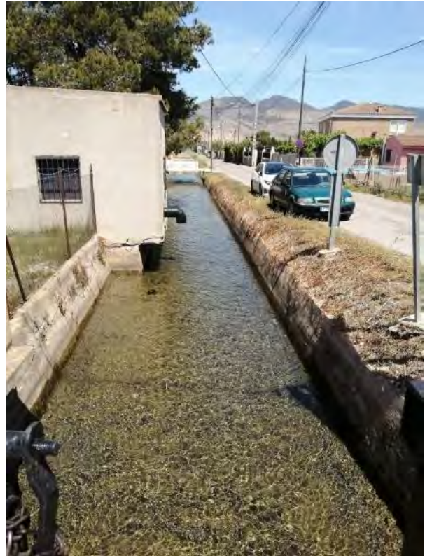
Figura 26: Séquia del Primer Canal (elaboración propia)
