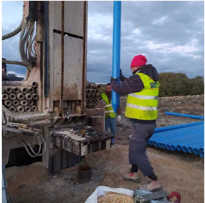
Figura 18: Entubación de un sondeo
