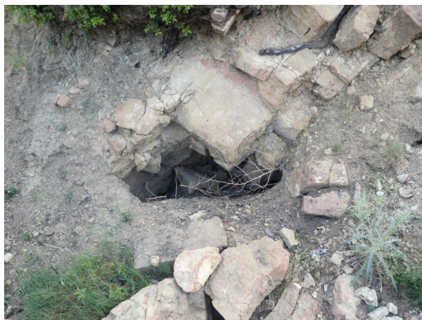
Boca casi tapada del refugio nº 2
