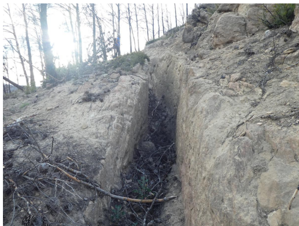
Tramo de trinchera en aceptable estado de conservación
