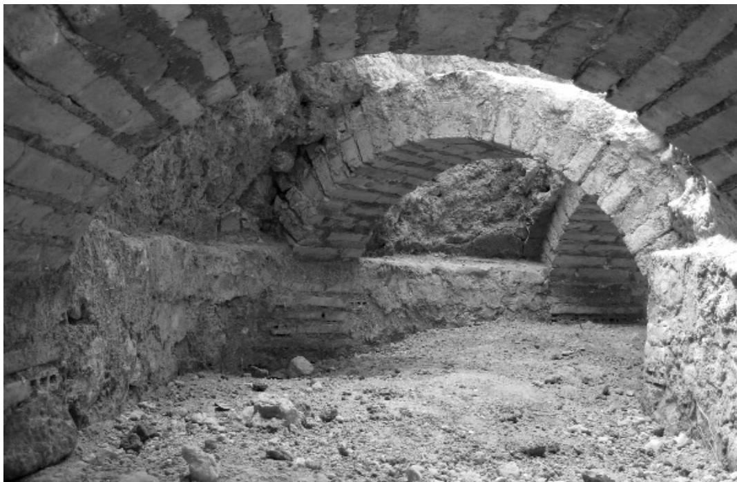
Fotografía 31: Una de las galerías del refugio del Parque aún rellena en parte de los escombros que la colmataban. Se aprecian los arcos de refuerzo realizados con ladrillos macizos.
