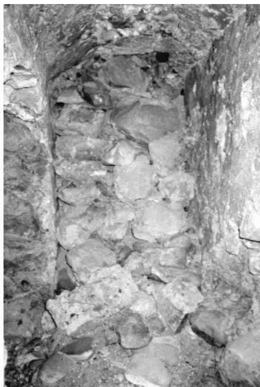
Fotografía 14: Detalle del final del túnel, cegado con un muro de mampostería tras la Guerra Civil.
