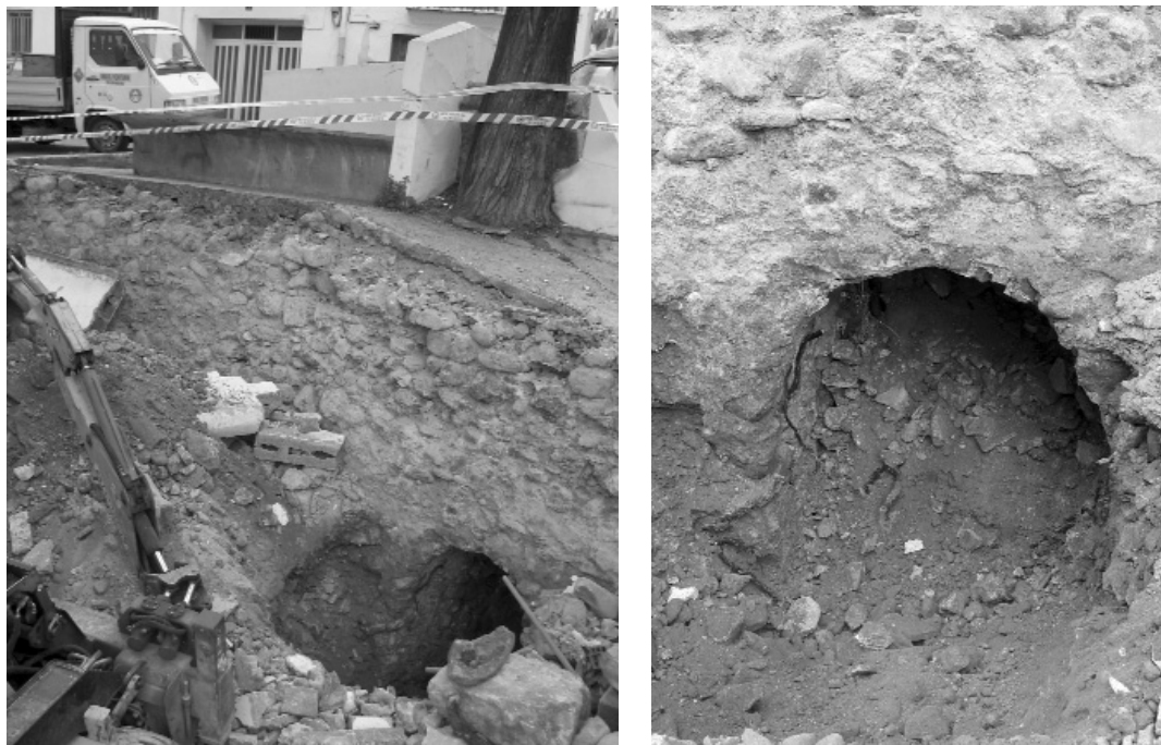
Fotografía 21 y 22: El refugio de la Calle Muralla, con la boca cegada por los escombros
