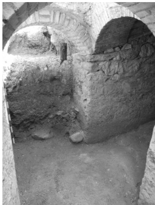
Fotografía 29: Aspecto del refugio del Parque tras su desescombros parcial.
