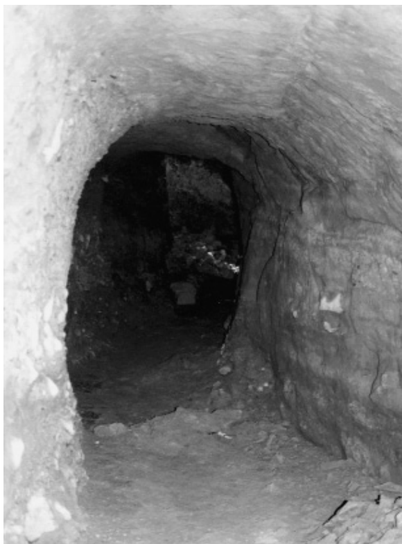
Fotografía 16: Aspecto de la galería del refugio de la Plaza de Las Monjas en su tramo inicial.
