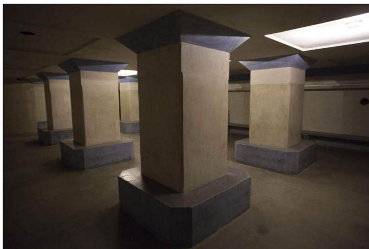
Interior del refugi del carrer Serrans a València (foto: Fernando Bustamente)
